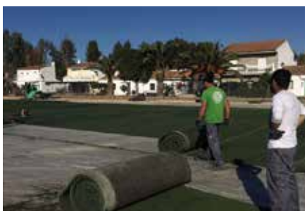
Construcción campo de fútbol Sotogordo
