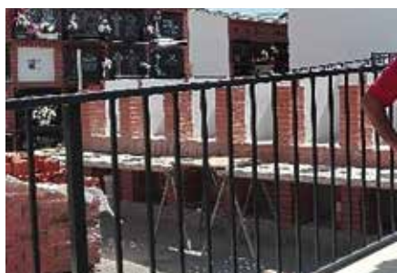
Construcción de nichos nuevos
