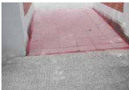
Eliminación de barreras arquitectónicas en el cementerio
