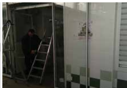
Puerta automática mercado de abastos
