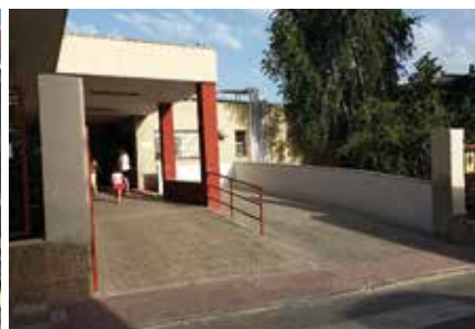
Construcción parque ambulancias en el centro de salud
